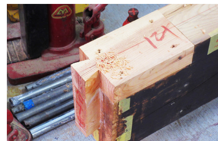
損傷している箇所は、必要な部分だけ新しい木材で継ぎ足し補強される。新旧の材が一緒になって新しい建物を支えていく。
