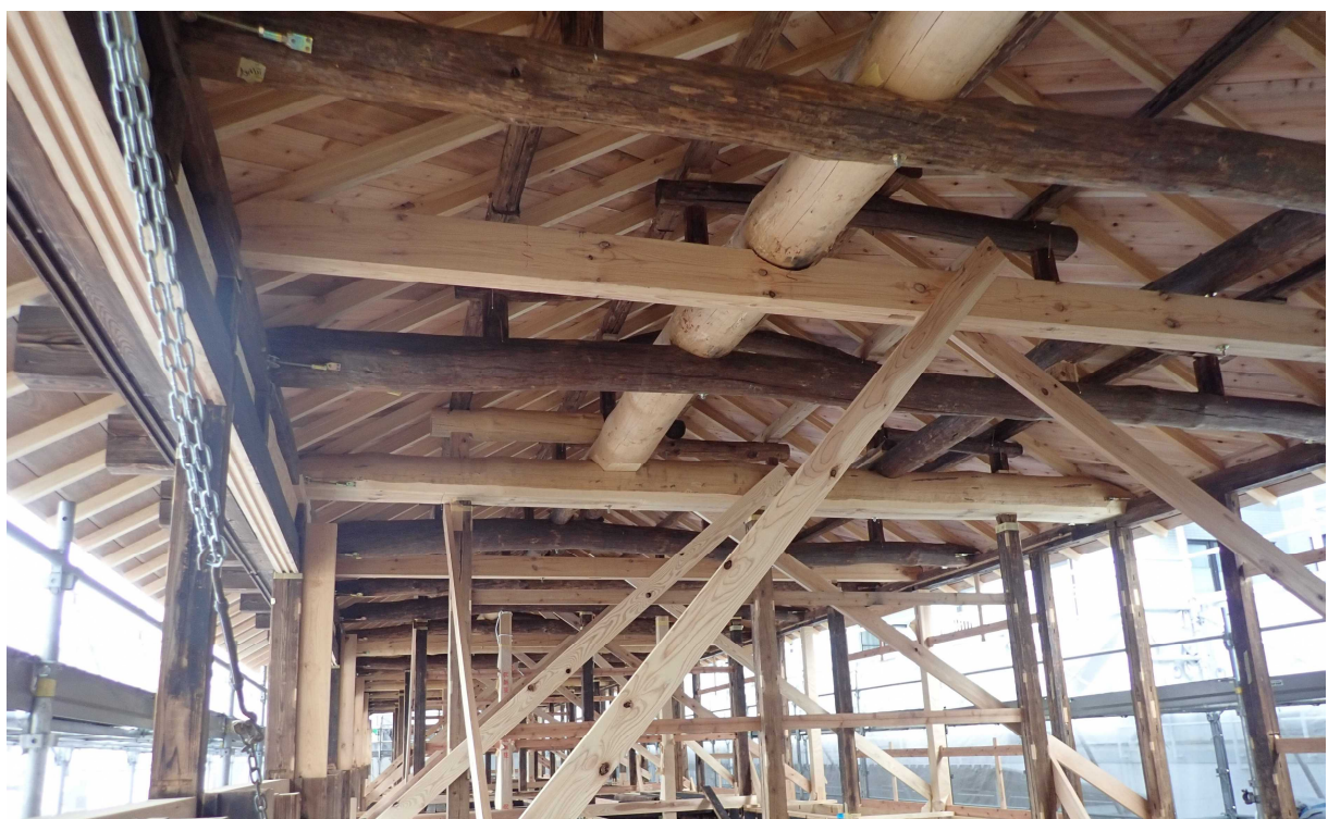
西棟小屋組みの写真
