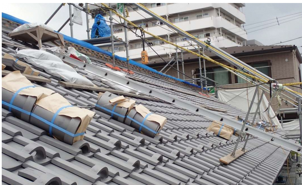
西棟の瓦工事
