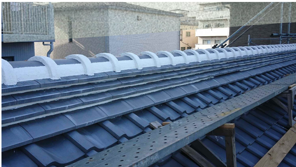
西棟屋根左官工事
