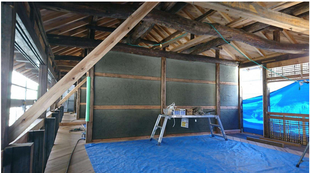
東棟の施工状況
