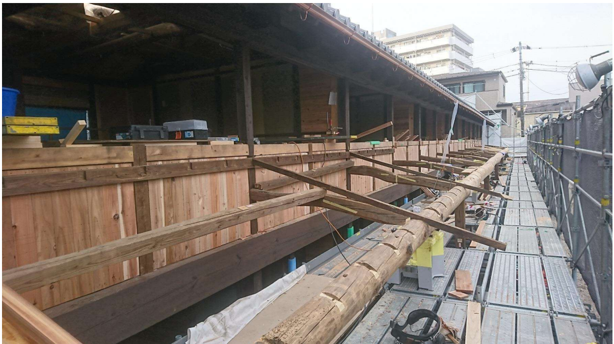
西棟土庇の施工状況
