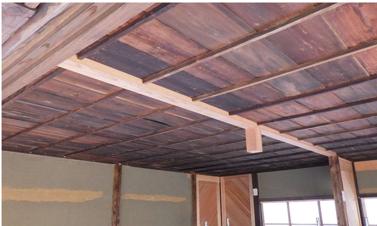
西棟2階の施工状況
