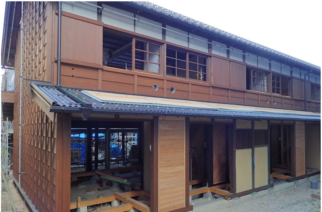
西棟西側の施工状況
