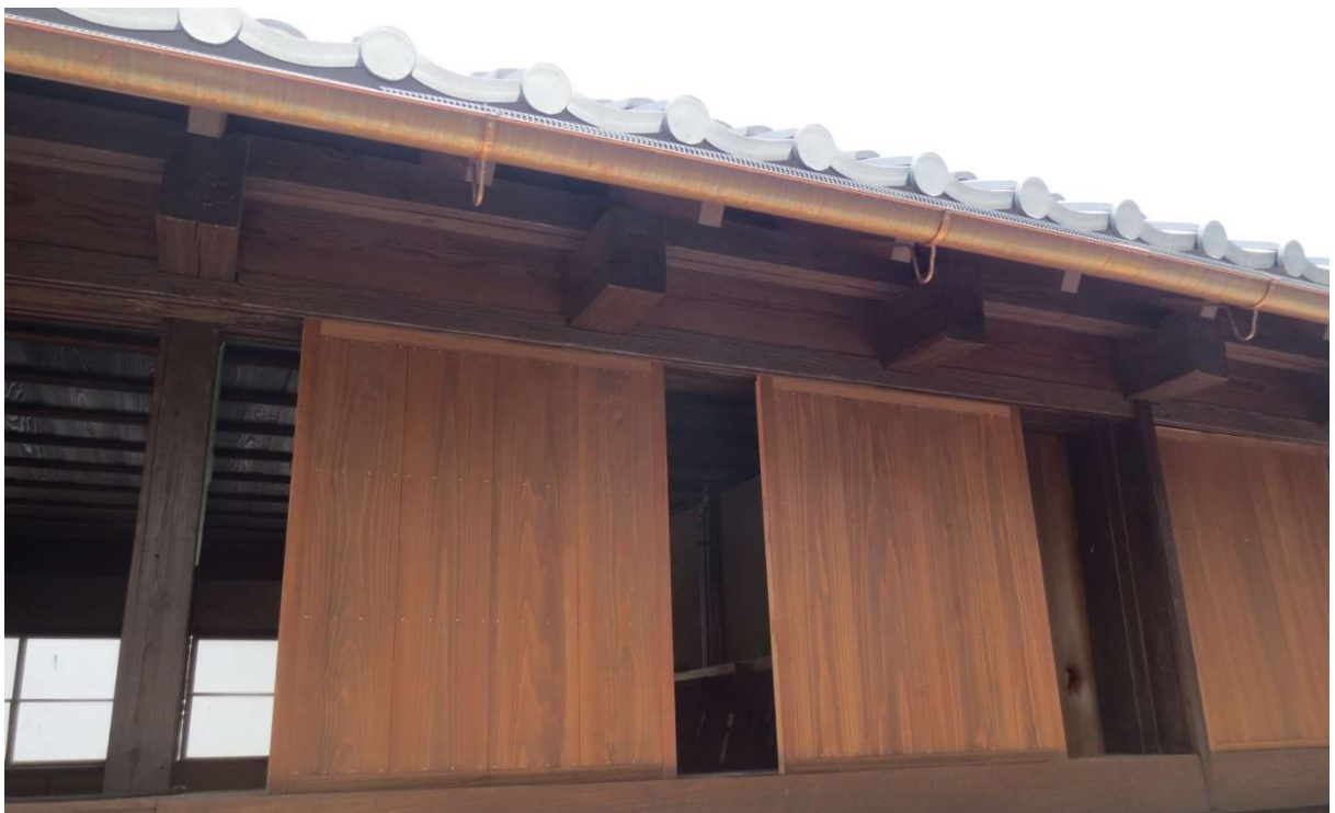
東棟2階の施工状況
