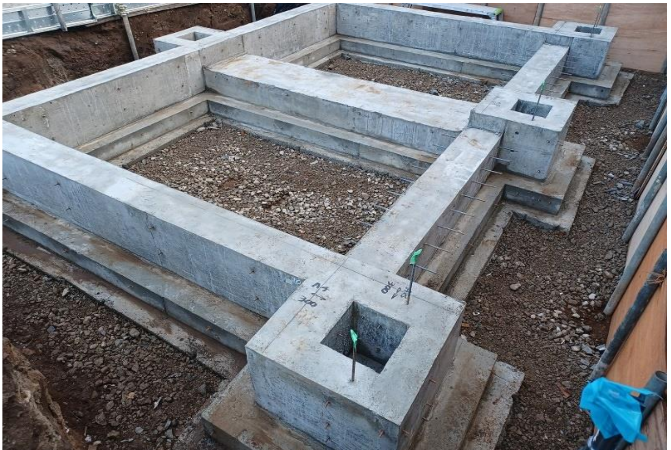
基礎コンクリート打設の施工状況
