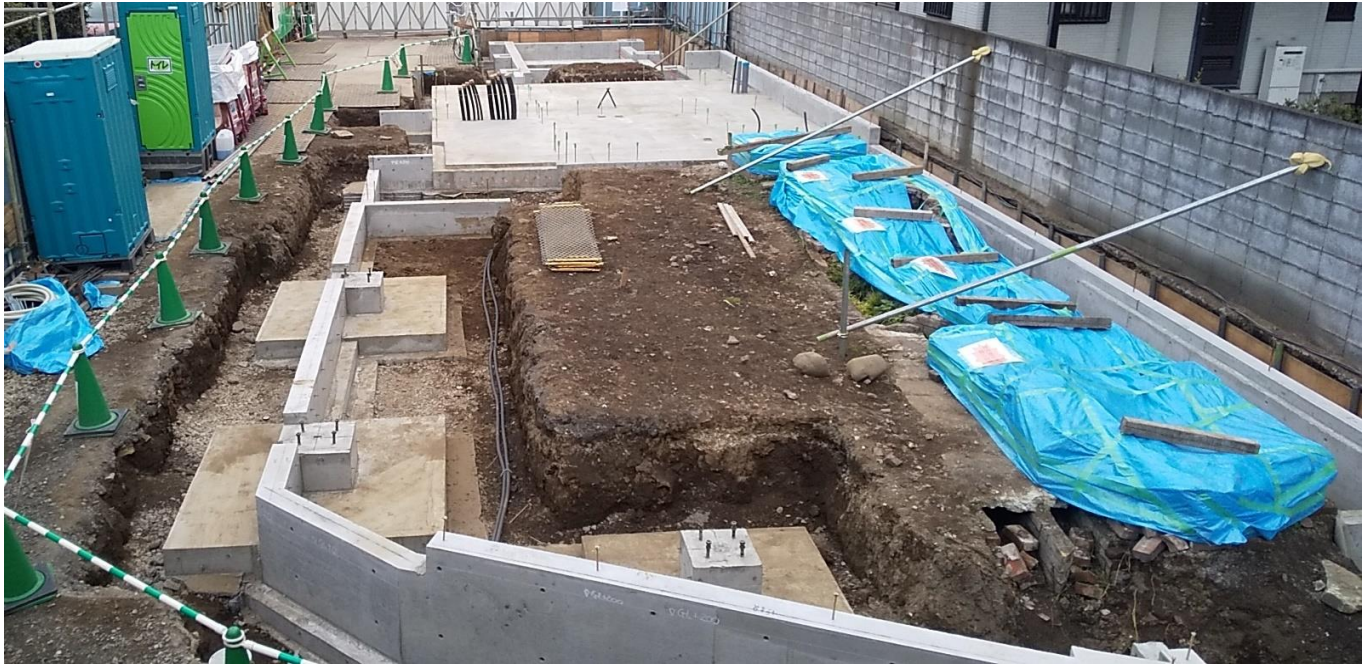
全景（令和4年11月 撮影）
