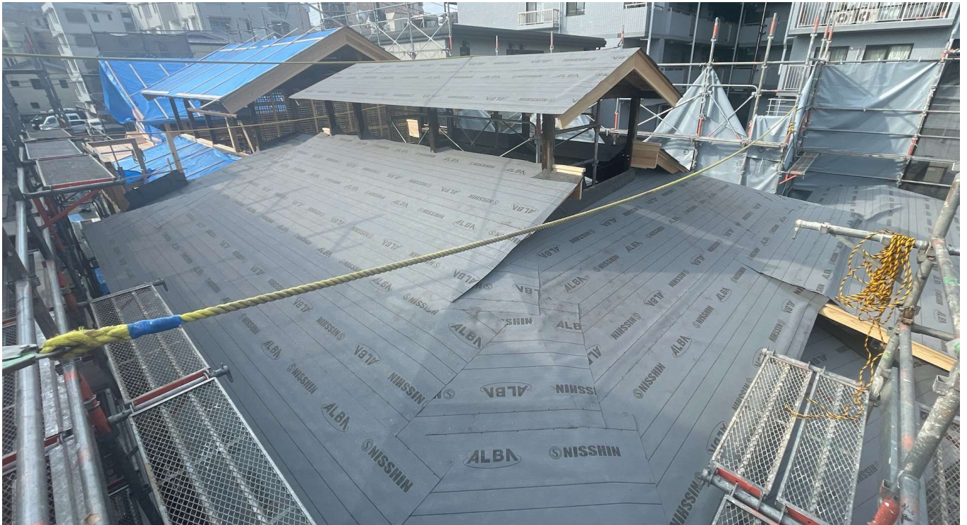
全景（令和5年2月 撮影）
