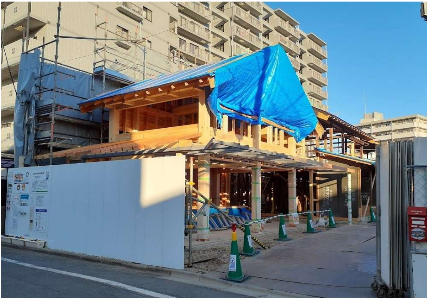
交流機能施設の施工状況
