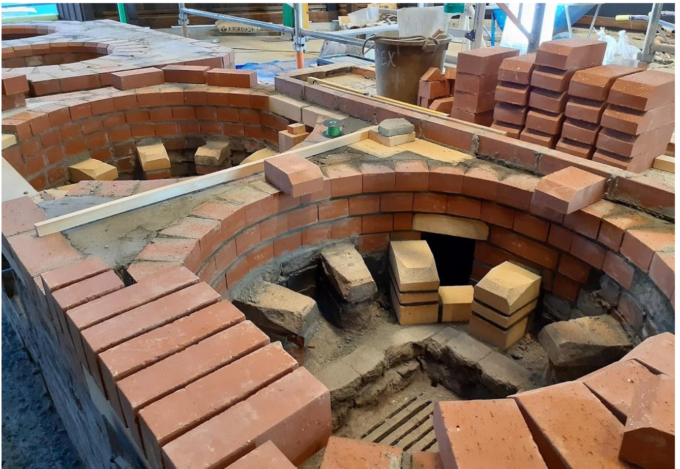
旧栄養食配給所炊事場棟カマドの施工状況
