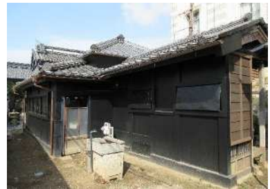
【第2期工事完了後】
