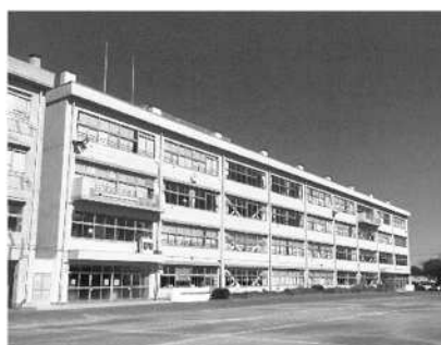
工事例(大規模改造)
