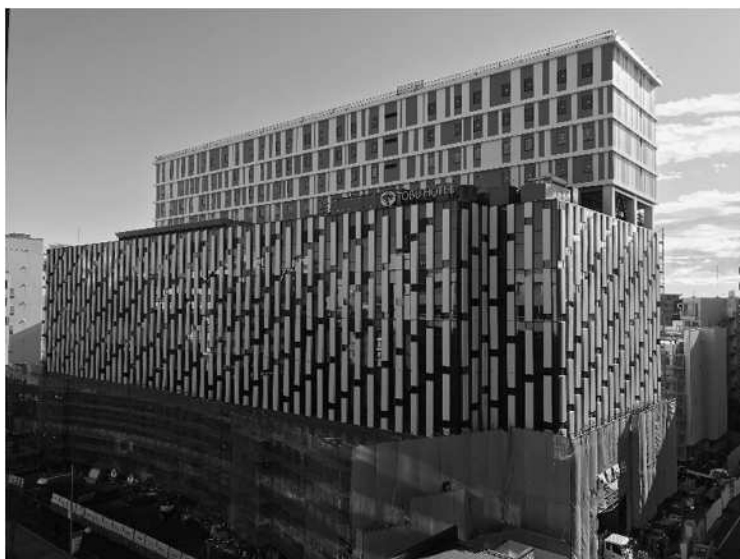
建設中の民間複合施設
