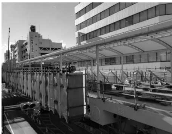
建設中の川越駅西口歩行者用デッキ
