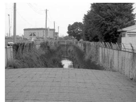
工事予定箇所(下流区間)
