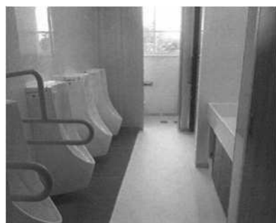
工事例(トイレ改修)
