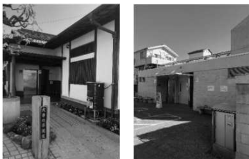
改修予定のトイレ(左:大手町、右:川越まつり会館屋外)
