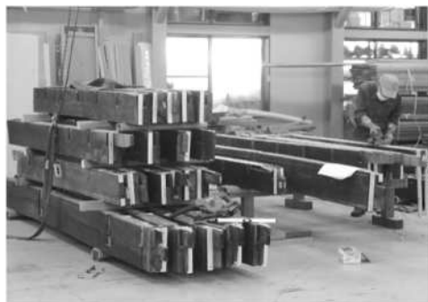
部材修復作業の様子
