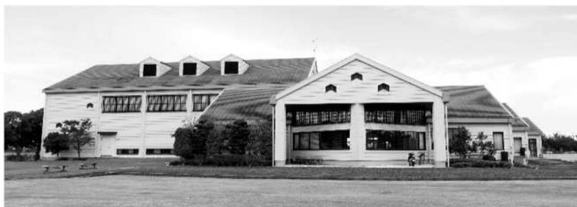
改修整備工事を予定している農業ふれあいセンター
