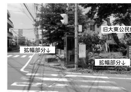
市道7476号線(南大塚1丁目地内)
