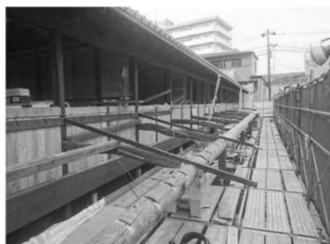
西棟土庇の施工状況
