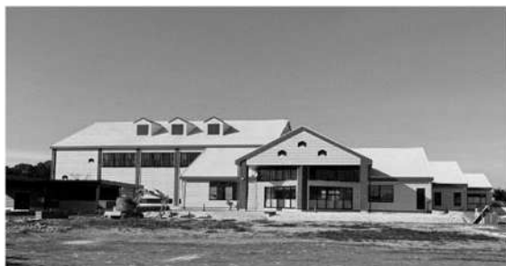
改修工事中の農業ふれあいセンター
