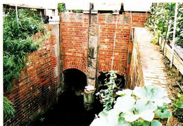
写真3 三軒家樋管（川越市洪井）
