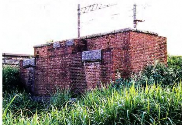
写真2 東武東上線入間川橋梁の的場側橋脚
