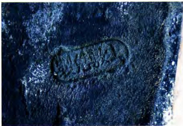
写真1 日本煉瓦製造（株）製造・刻印煉瓦
