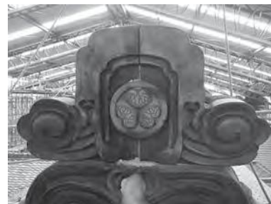
写真3 解体前の南側鬼瓦
