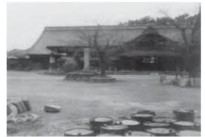
写真2 昭和42年以前の本丸御殿南側屋根
