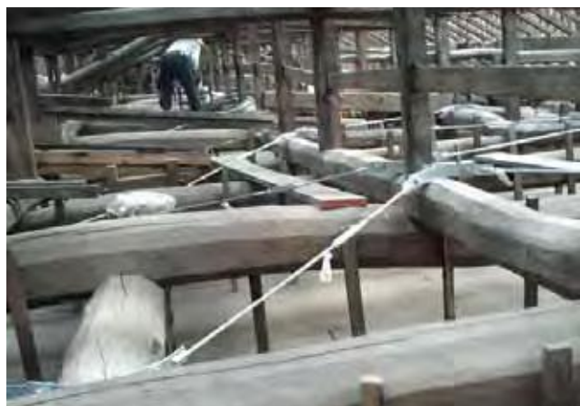
水平ブレースの設置
