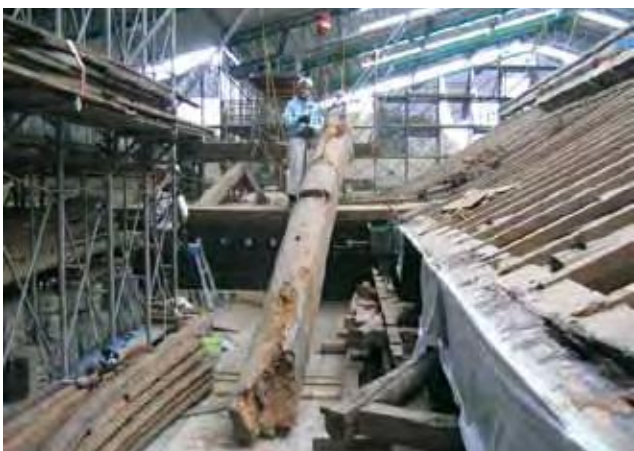
既存小屋梁の撤去
