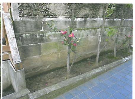
写真3 塀N基礎部分近景 房州石4段積で、5段目はモルタルに よる石積風仕上げ。
