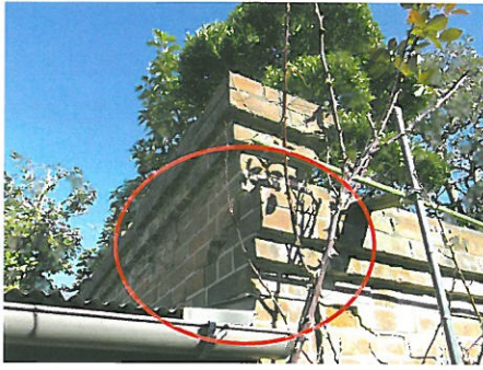
写真4 敷地南西隅塀Sw - W接続部 塀Swの笠木部分が崩れ、塀Wが積み直されている。
