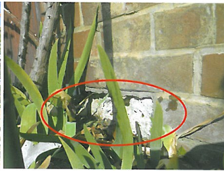
写真5 同最下部 煉瓦の下、基礎に伊豆産の凝灰岩が用いられている。
