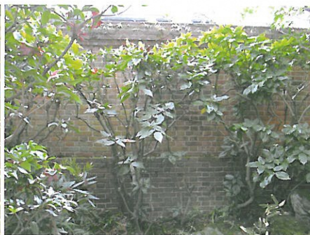
写真2 塀Sw近景 基礎は煉瓦積。笠木の高さは塀Seと 同じだが、基礎の高さはこちらが高い。
